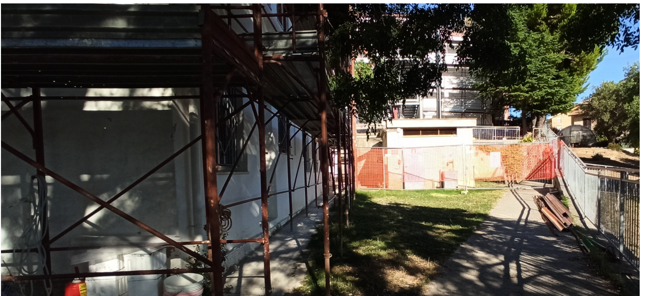
Area 02 – Vista (attualmente in parte occupata da un cantiere comunale in smantellamento)
